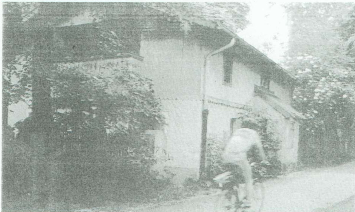
DER VERFALL WIRD GESTOPPT. Bis Jahresende soll das Lola-Montez-Haus entweder saniert oder abgerissen und nach Originalplänen wiederaufgebaut werden. Photo: Horlbeck
